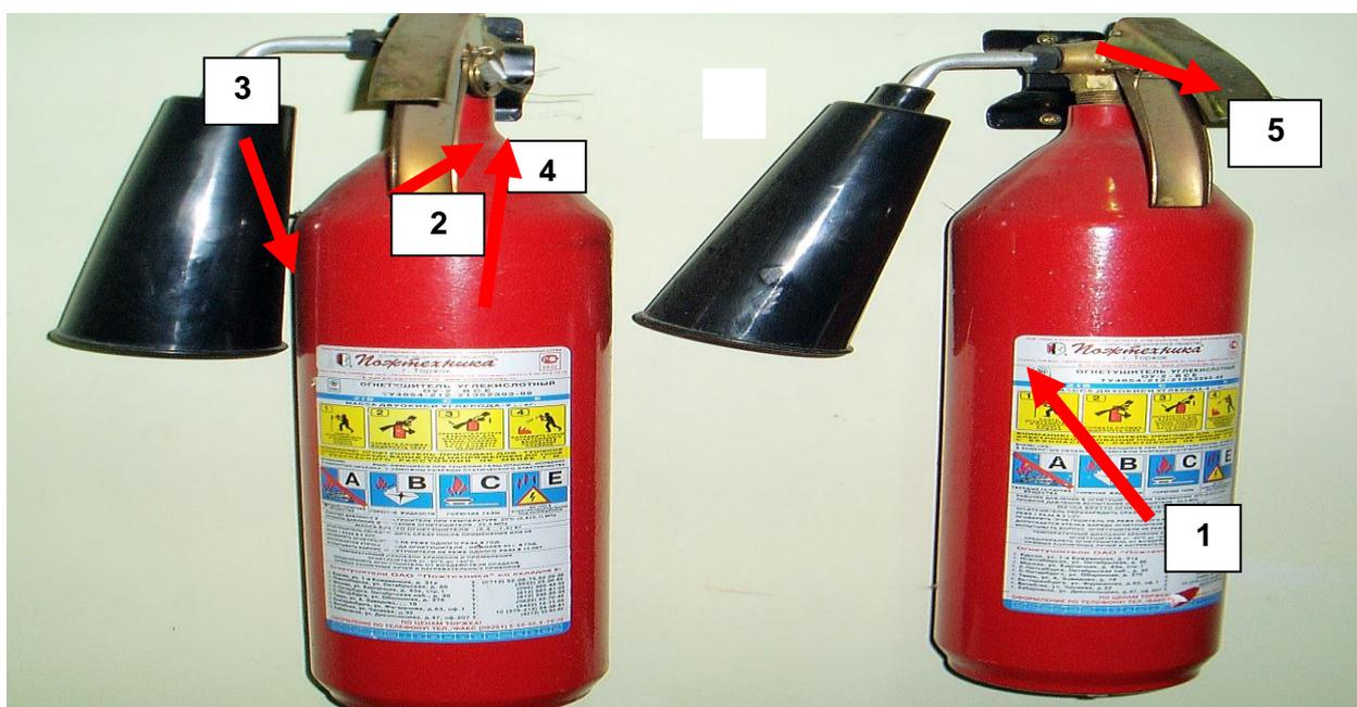
1. Запорно-пусковое устройство. 2. Корпус с зарядом (двуокись углерода). 3. Раструб.
